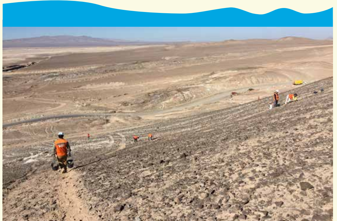
Tránsito del personal, sobre huellas existentes.
