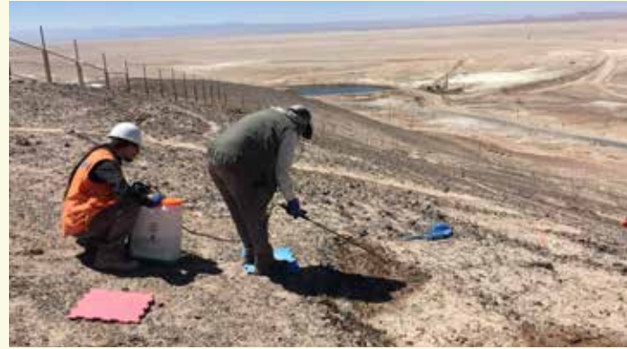
Humectación con agua.
