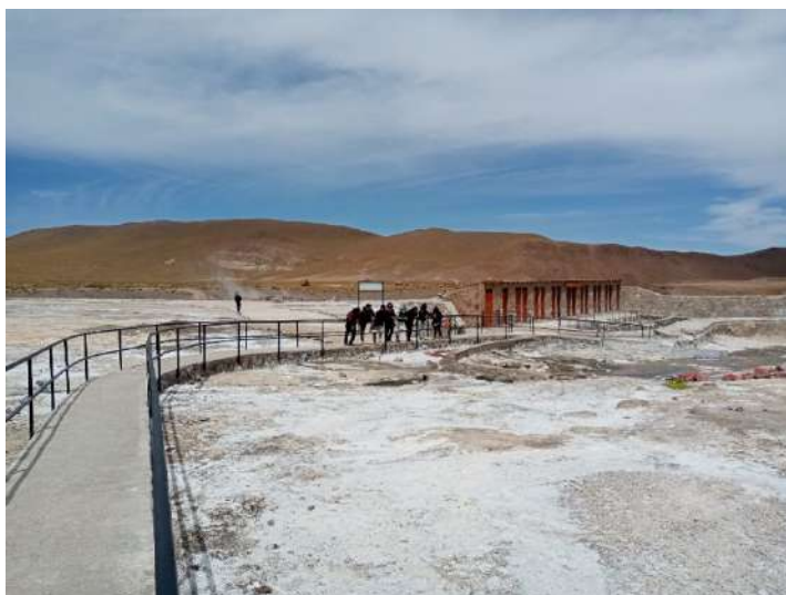
Imagen 2 Pasarela en Geiser del Tatio
